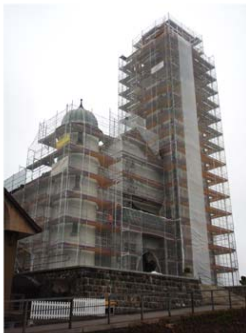
Bild 2 Regelkonformes Fassadengerüst
