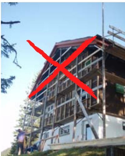
Bilder 5 bis 7 Mangelhafte, unzulässige Fassadengerüste
