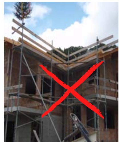
Bild 4 Ist der Fassadenabstand grösser als 30 cm, sind Massnahmen zu treffen.
