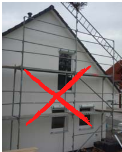
Bild 4 Ist der Fassadenabstand grösser als 30 cm, sind Massnahmen zu treffen.
