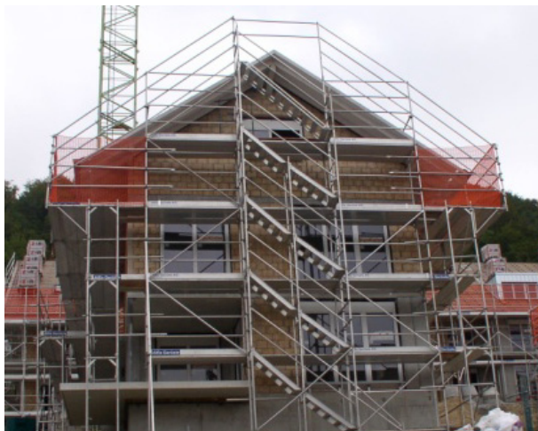
Bild 3 Fassadegerüst mit korrekt erstelltem Treppenturm
