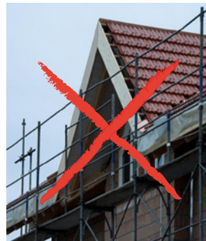
6 und 7 So nicht: unwirksame Dachdeckerschutzwände
