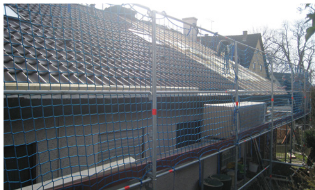
3 Korrekt erstellte Dachdeckerschutzwand mit Auffangnetz.
