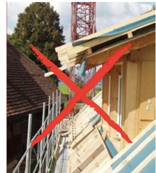
6 und 7 So nicht: unwirksame Dachdeckerschutzwände
