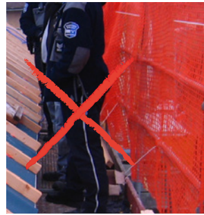
5 Polizei und Untersuchungsbehörden ermitteln die Unfallursache: mangelhafte, mit Kabelbindern unsachgemäß befestigte Dachdeckerschutzwand.
